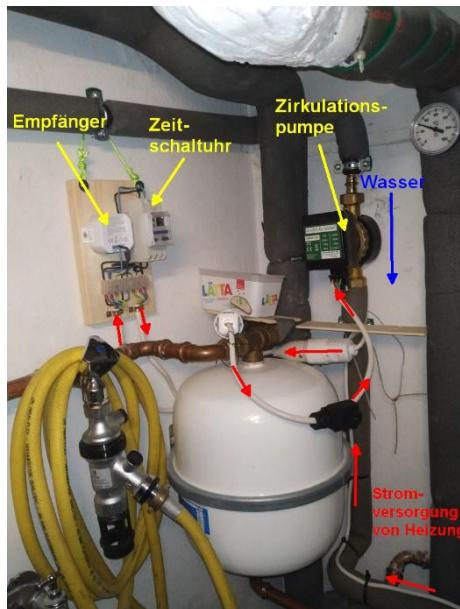
Wenn die Pumpe mal wieder nicht läuft, ist vermutlich das Flügelrad verklemmt.
