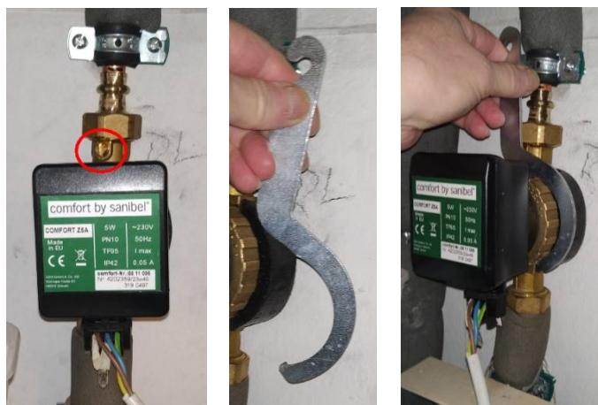
Das Losdrehen der Überwurfmutter geht sehr schwer. Der Motor wird sich mitdrehen, also Stecker vorher abziehen.
